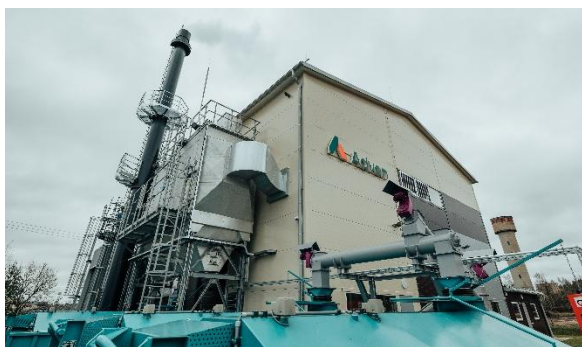
5. foto. Katlu māja Rietekļa ielā 1.
