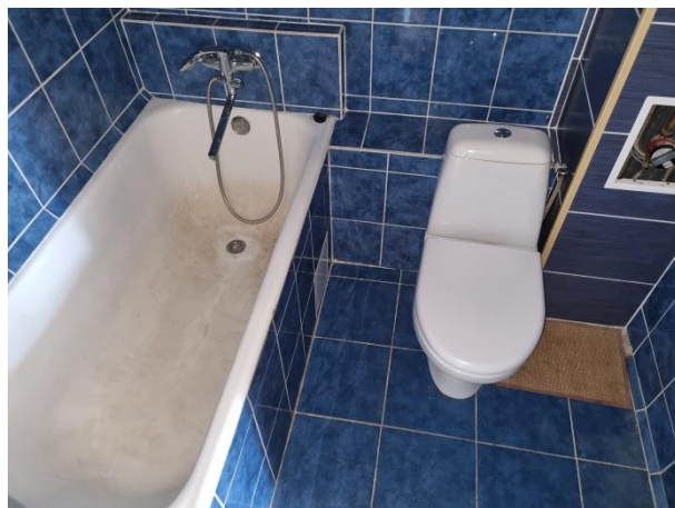
Savienotā sanitārtehniskā telpa
