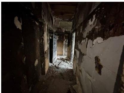
Ēkas pirmā stāva iekštelpas
