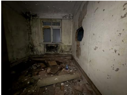
Ēkas pirmā stāva iekštelpas
