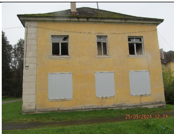
Ziemeļu fasāde kreisā puse
