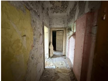
Ēkas otrā stāva iekštelpas
