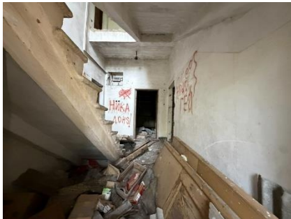
Ēkas pirmā stāva iekštelpas
