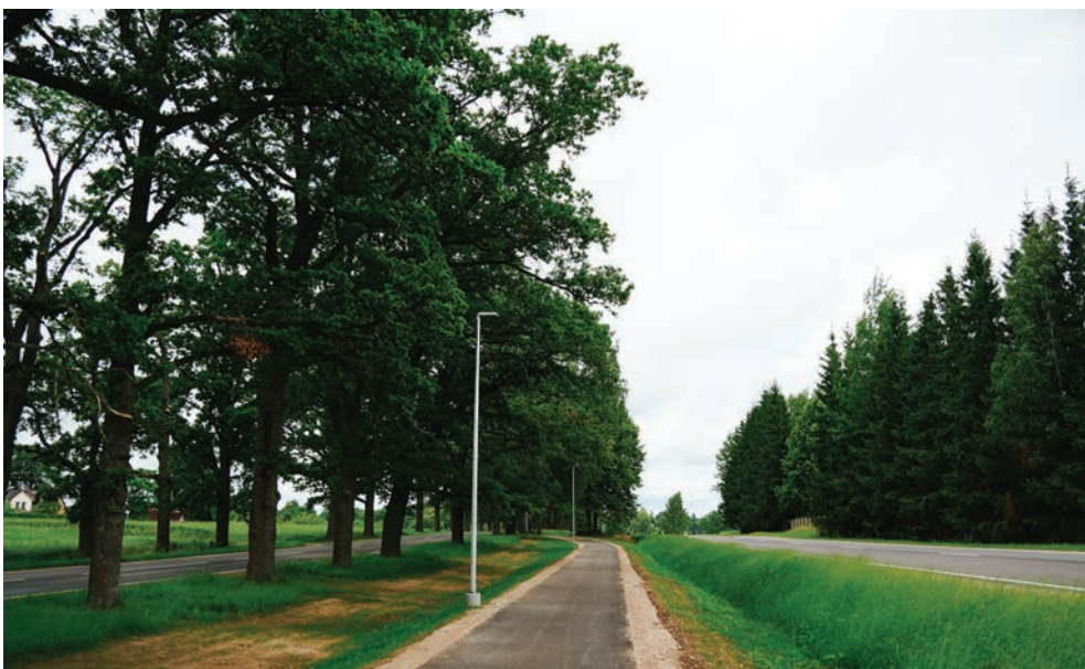
Jaunā gājēju un velosipēdu infrastruktūra starp autoceļu P20 brauktuvē
