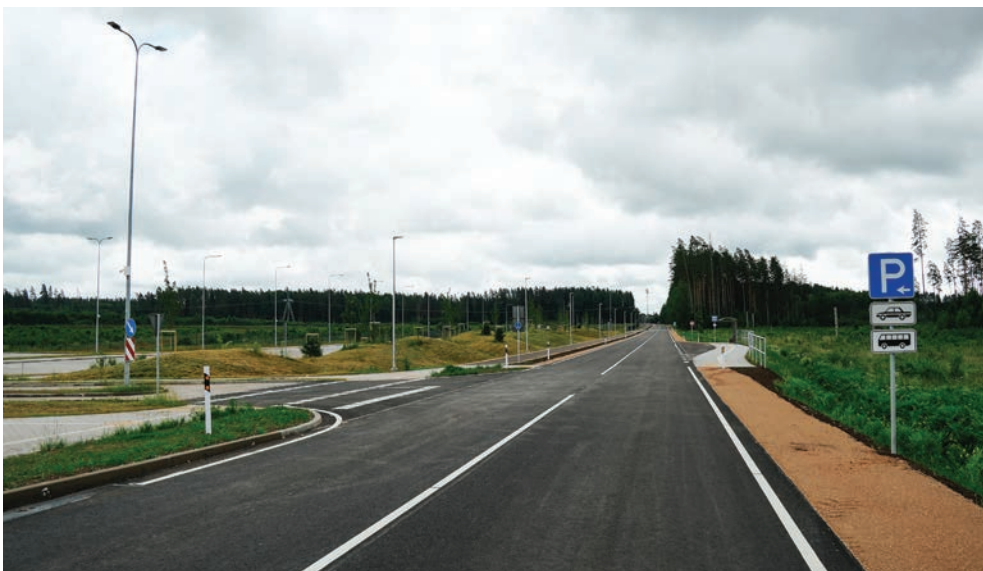
Pārbūvētais autoceļš V184 Dumbrāji–Zeiboti gar Valmieras Industriālo parku
