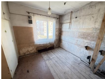
Kabinets (telpa Nr.7)
