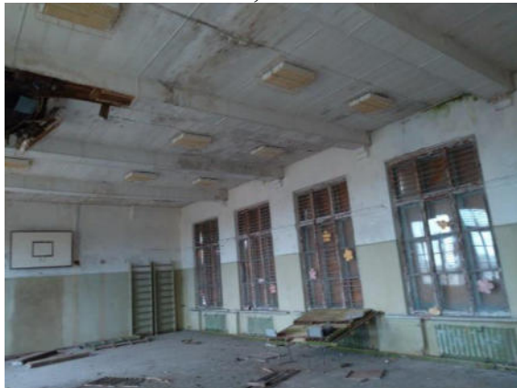
21.attēls. Iekšskats nedzīvojamās ēkas 3.stāvā (zāle)
