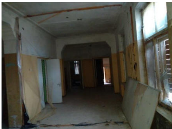
17.attēls. Iekšskats nedzīvojamās ēkas 1.stāvā
