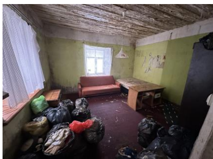
Dzīvojamās ēkas pirmā stāva telpas
