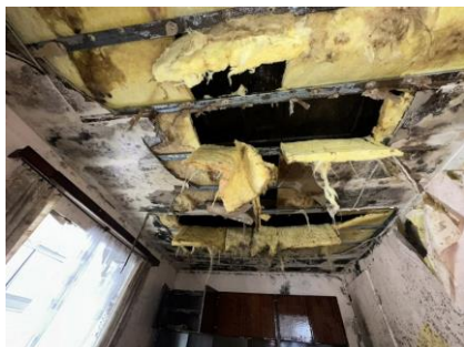
Dzīvojamās ēkas pirmā stāva telpas
