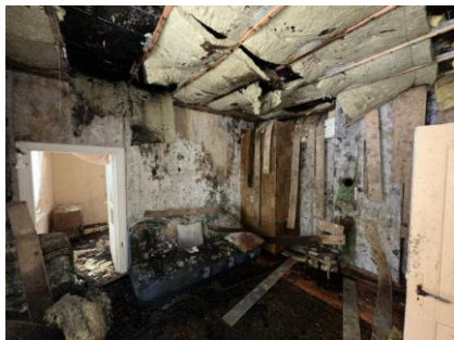
Dzīvojamās ēkas pirmā stāva telpas
