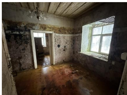
Dzīvojamās ēkas pirmā stāva telpas
