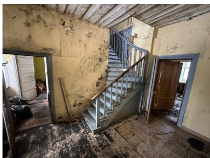
Dzīvojamās ēkas pirmā stāva telpas
