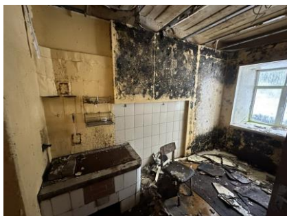
Dzīvojamās ēkas pirmā stāva telpas
