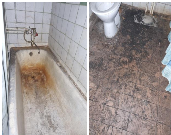
Savienotā sanitārtehniskā telpa
