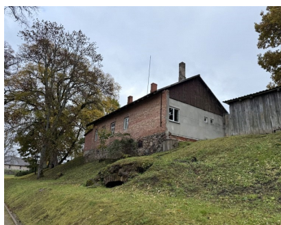
Fasāde no Kocēnu dīķa puses
