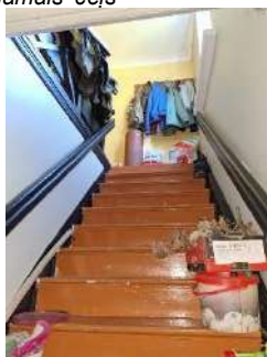
Koplietošanas telpa, kāpņu telpa
