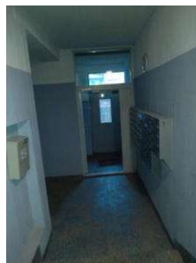
4.attēls. Kāpņu telpa
