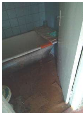
14.attēls. Tualete (telpa Nr.4)
