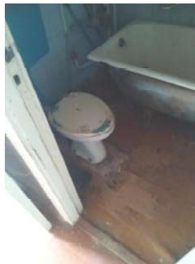
12.attēls. Tualete (telpa Nr.4)
