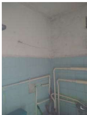
13.attēls. Tualete (telpa Nr.4)
