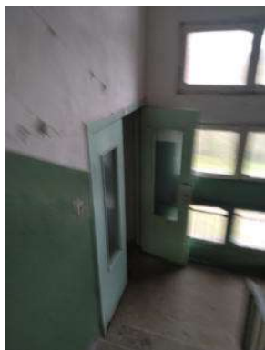
3.attēls. Kāpņu telpa
