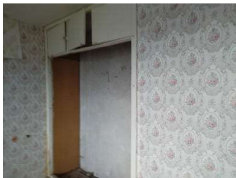
13.attēls. Sienas skapis (telpa Nr.5)
