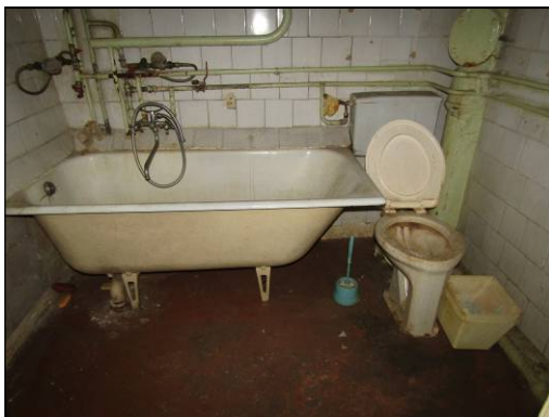
Skats uz savienoto sanitārtehnisko telpu
