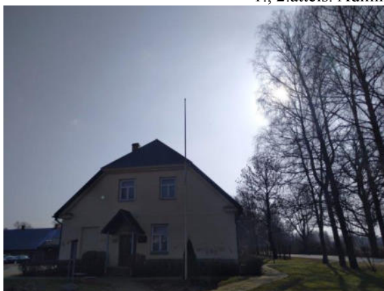
3.attēls. Administratīvā ēka (sānskats)
