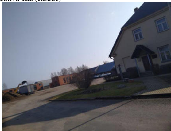
4.attēls. Iebrauktuve teritorijā
