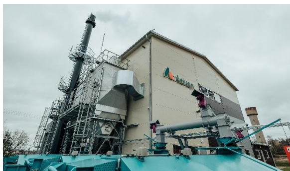
5. foto. Katlu māja Rietekļa ielā 1.
