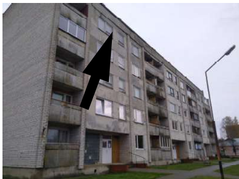
1.attēls. OBJEKTA atrašanās vieta ēkā
