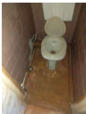
15.attēls. Tualete (telpa Nr.6)
