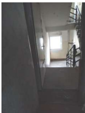
3.attēls. . Kāpņu telpa
