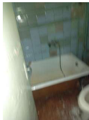
12.attēls. Tualete (telpa Nr.4)
