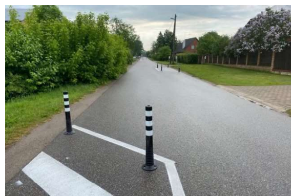
Attēls 16. Ielas sašaurinājums ar stabiņiem 6
