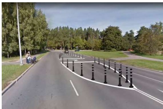
Attēls 15. Ielas sašaurinājums ar stabiņiem 5
