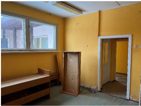
Bērnu dārza ēkas iekštelpas
