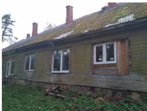
1 attēls. Dzīvojamās mājas fasāde
