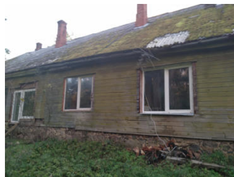
2. attēls. Dzīvojamās mājas fasāde
