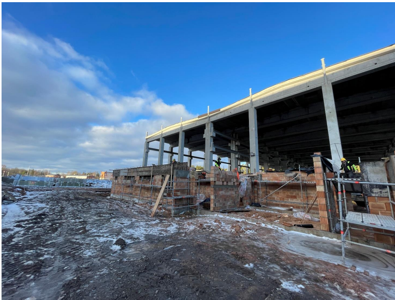
Dienvidu fasāde. Apskates brīdī notiek administratīvi-saimniecisko telpu apjoma mūrēšanas darbi
