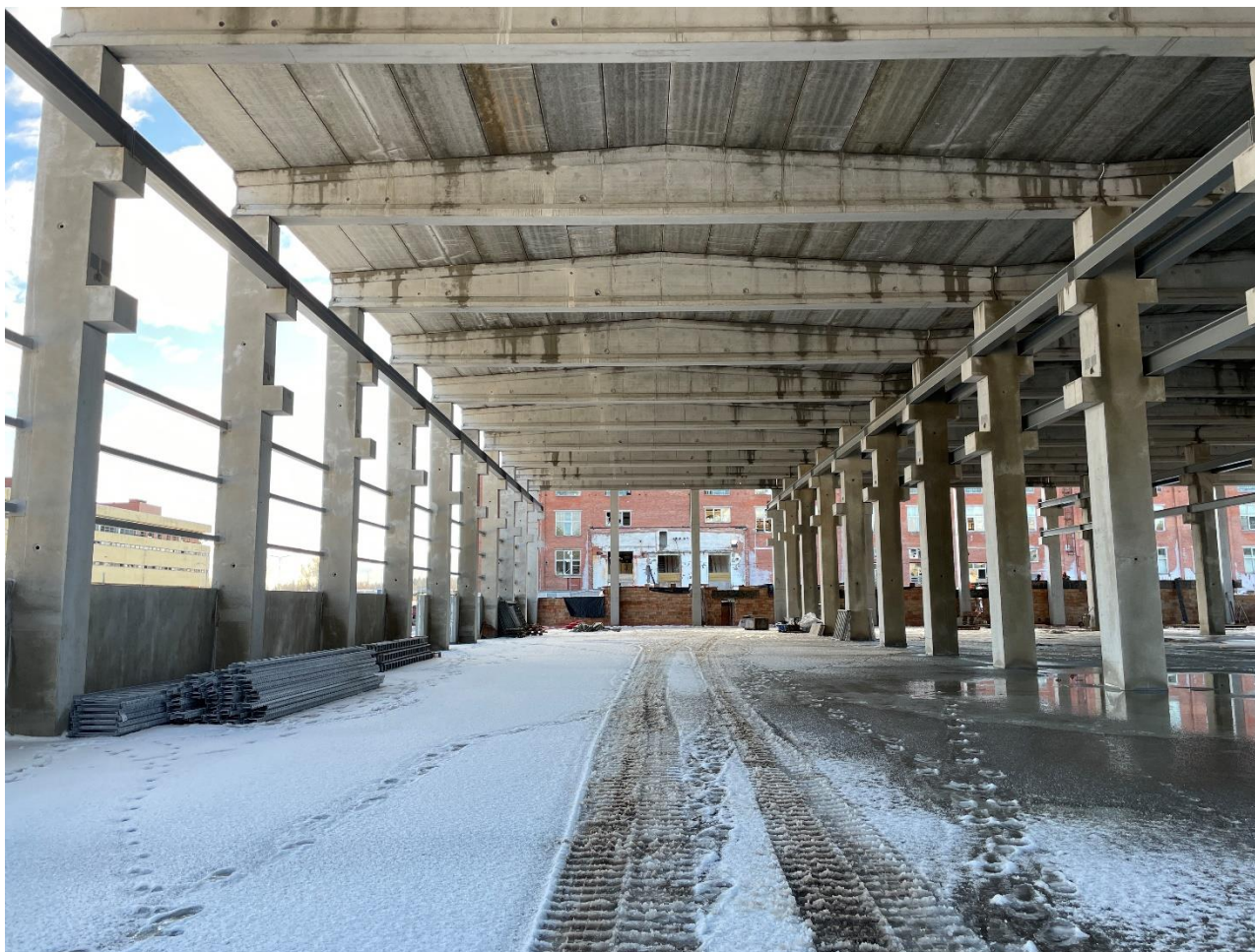
Ražošanas telpu kopskats. Dzelzsbetona karkass ar pārsegumu un tērauda sijām, uz kurām nepieciešamības gadījumā iespējams uzstādīt tilta celtni.
