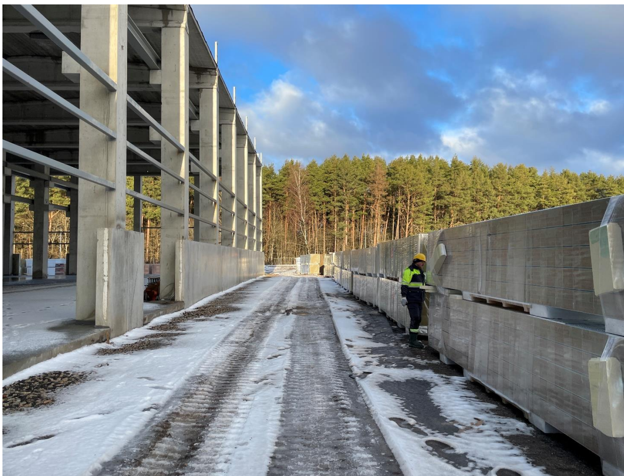
Austrumu fasāde. Būvniecības process. Montāžai sagatavoti sienu paneļi.
