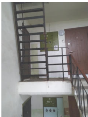
3.attēls. Kāpņu telpa
