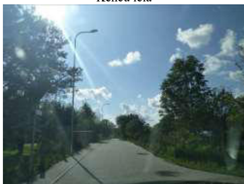
3.attēls. Vērtējamo inženierbūvju atrašanas vieta Liepu ielā
