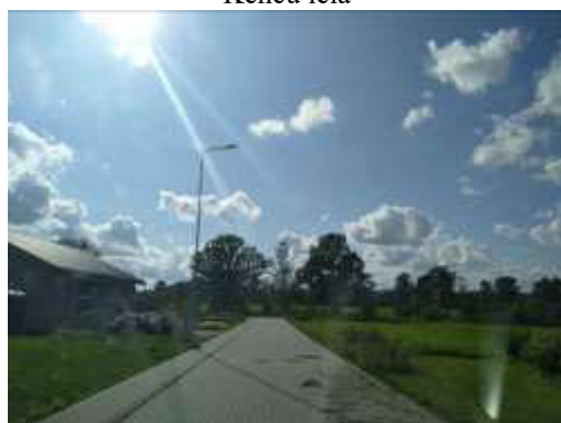
4.attēls. Vērtējamo inženierbūvju atrašanas vieta Liepu ielā
