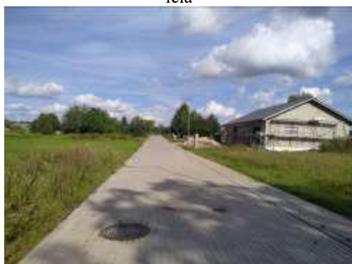
5.attēls. Vērtējamo inženierbūvju atrašanas vieta Liepu ielā
