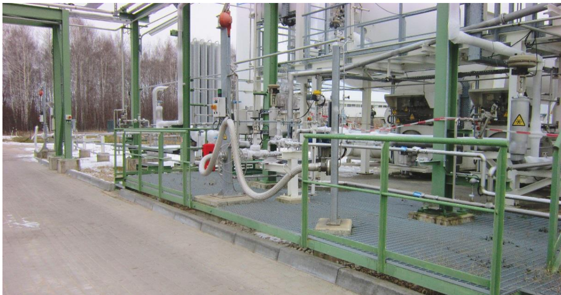
3.5. attēls. Tehnoloģiskais aprīkojums autocisternu uzpildes vietā.
