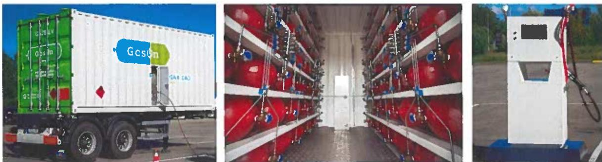
3.1. att. CNG piegādes konteinera ārpuse, iekšpuse un automašīnu uzpildes dispensera modulis
