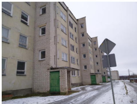
1.attēls. Dzīvojamās mājas fasāde
