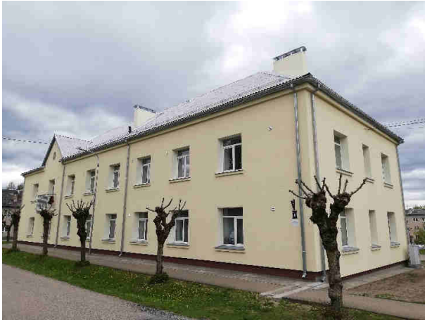
Dzīvojamās ēkas fasādes daļa no Imanta ielas puses (A puses)
