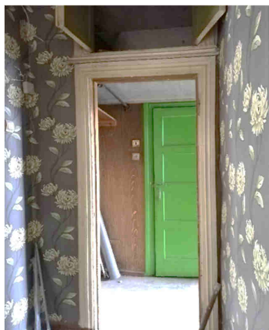
Gaitenis, telpa Nr. 1 pēc plāna
