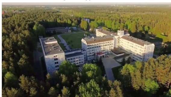
Attēls 60. Vidzemes slimnīca. 206
