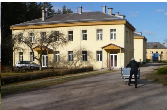
Attēls 54. Sociālās aprūpes un rehabilitācijas centrs "Seda". 193
