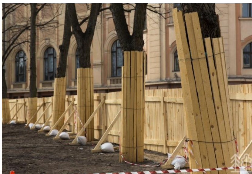
14. attēls. Piemērs koku aizsardzībai būvdarbu laikā
