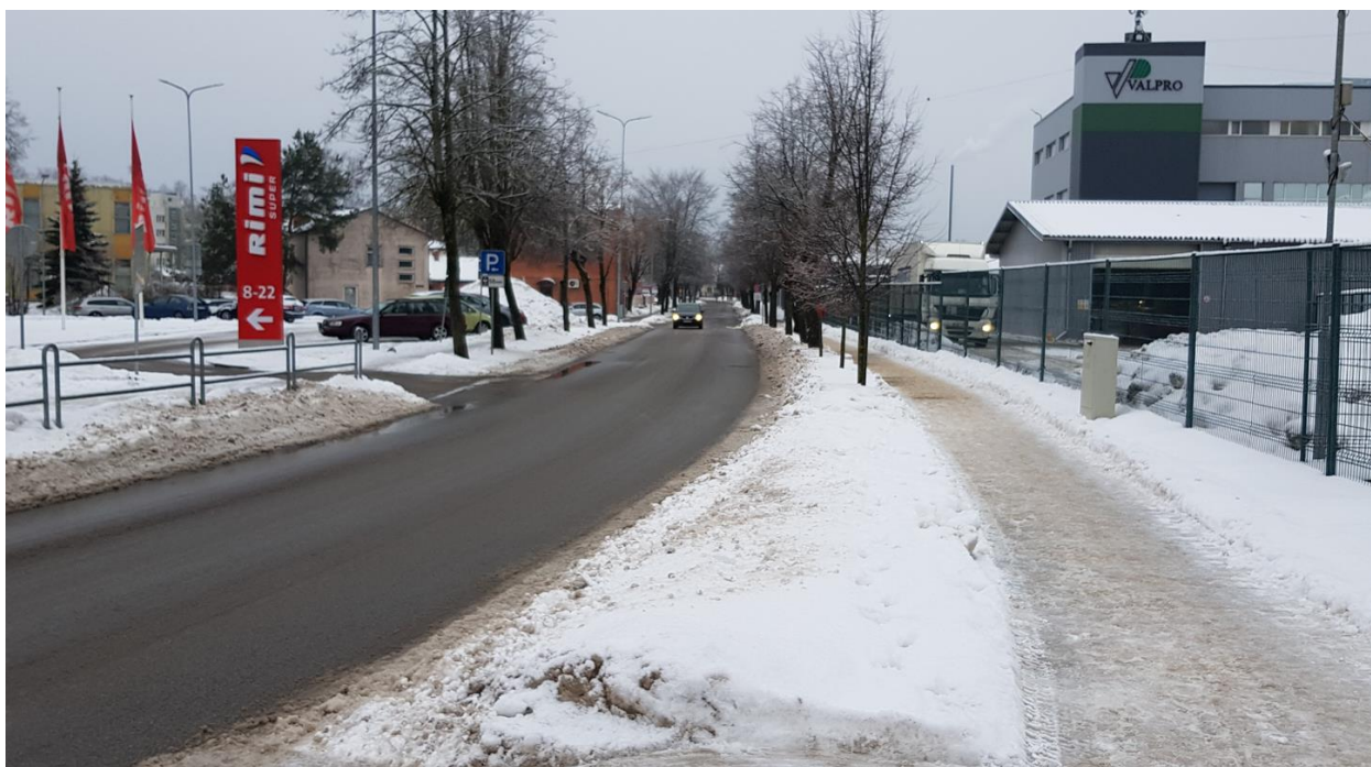
3.attēls. Skats uz trases sākumu gar SIA VALPRO teritoriju. Ielas abās pusēs ir esoši kokaugi. Atsevišķās vietās uz brauktuves iesēdumos uzkrājas ūdens.
