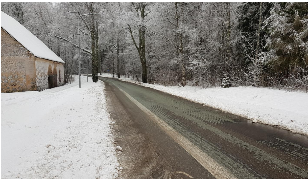
11.attēls. Cēsu ielā posmā no vecā dzelzceļa līdz Kauguru ielai ir veikta seguma labošana ar virsmas apstrādi. Velojoslas apzīmējums daļēji nodilis un klāts ar sniegu un apledojumu
