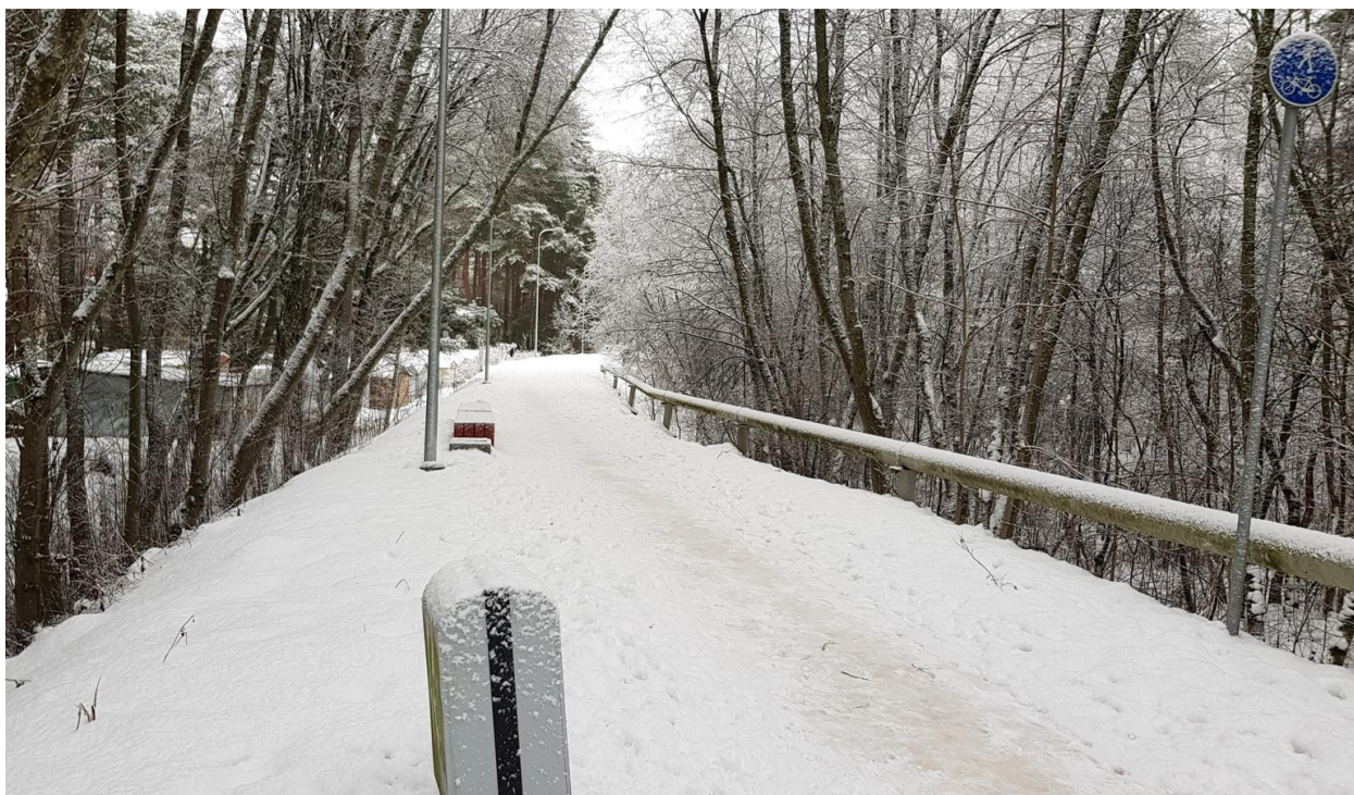
9.attēls. Esošais dzelzceļa uzbērumums ir labiekārtots kā gājēju un veloceļš un aprīkots ar soliem un atkritumu urnām, kā arī apgaismojumu
