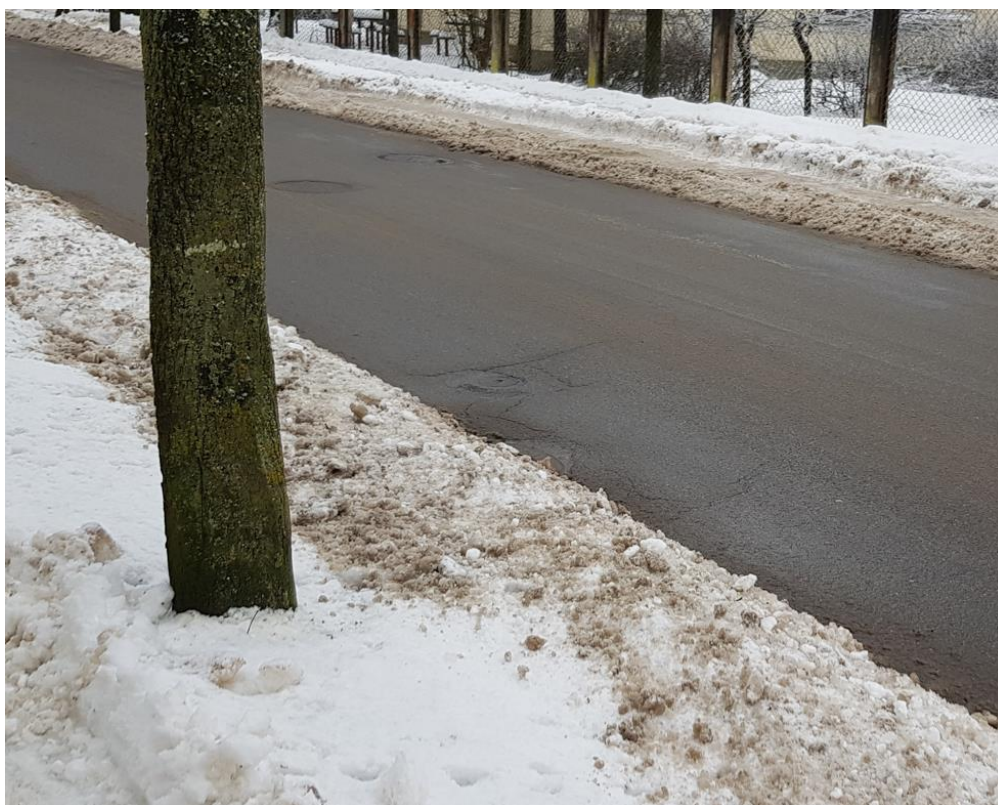
5.attēls. Esošie komunikāciju aku vāki un kapes ir iesēdušies segumā
