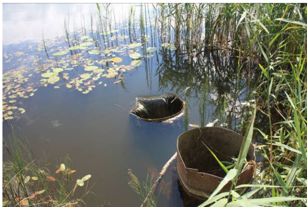
42., 43. att. Laņģupītes uzpludinājums - Lodes dzirnavezers. Attēlā pa labi -bīstami izveidota ūdens ieklūde slūžās.
