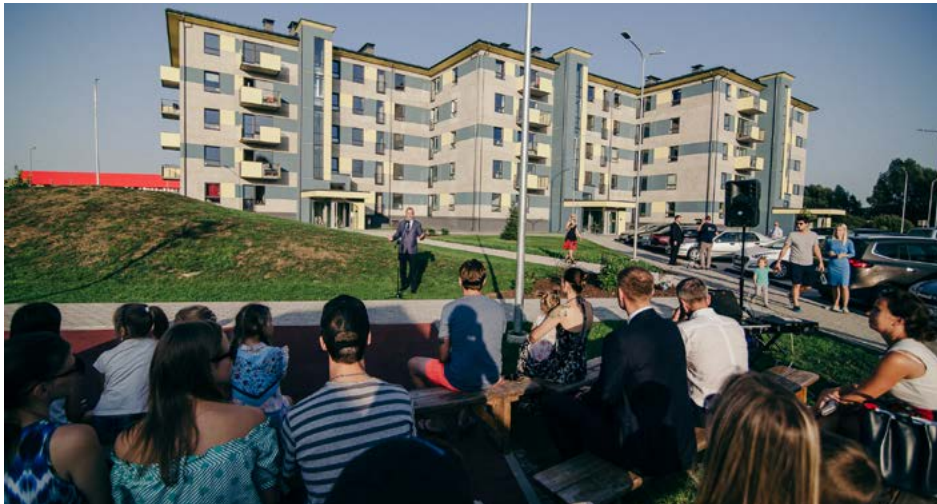
Daudzdzīvokļu īres nami Valmierā. Foto: Roberts Āboltiņš
