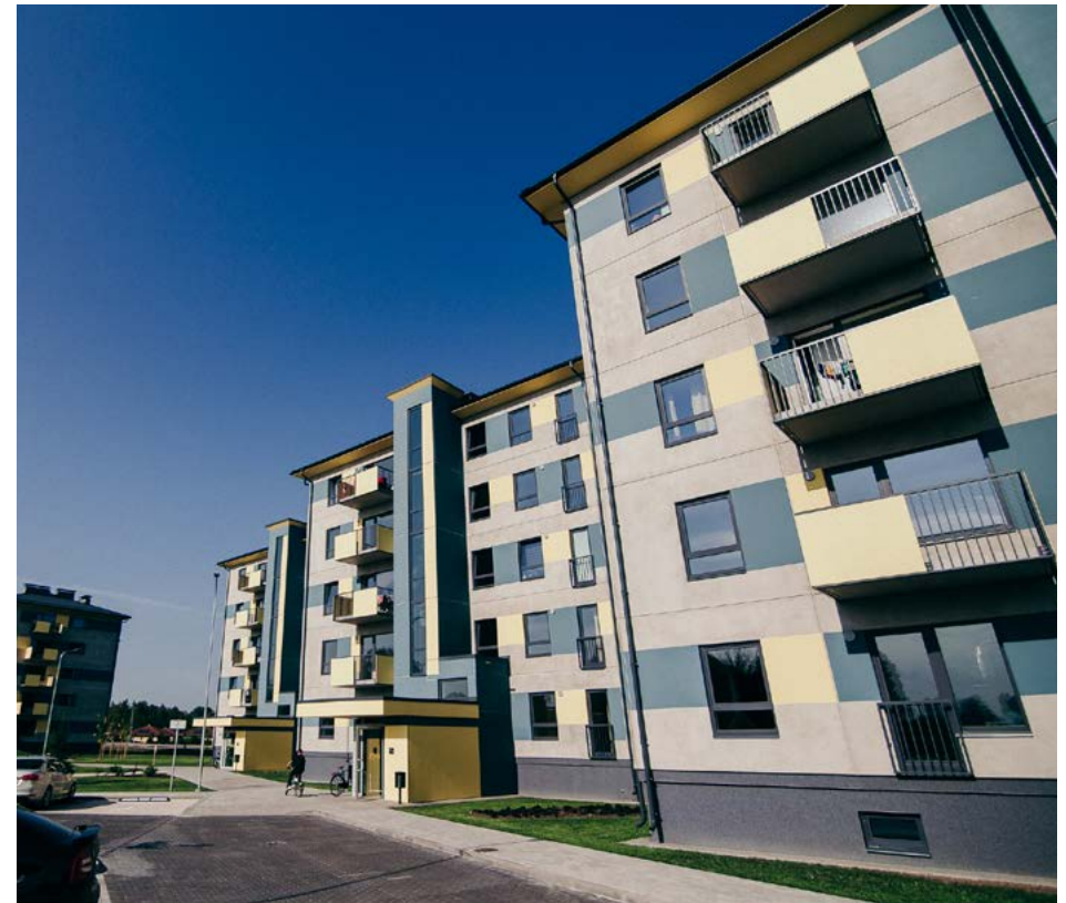
Daudzdzīvokļu īres nami Valmierā. Foto: Roberts Āboltiņš
