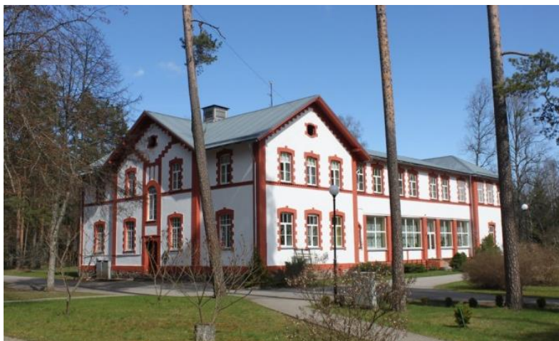
Attēls 29. Strenču psihoneiroloģiskā slimnīcas komplekss. 86
