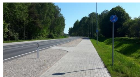
Attēls 5.26: Kopīga gājēju un velosipēdu ceļa pārtraukums Cempu ielā
