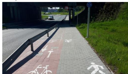
Attēls 5.23: Gājēju un velosipēdu ceļš Paula Valdena ielā pie dzelzceļa pārvada
