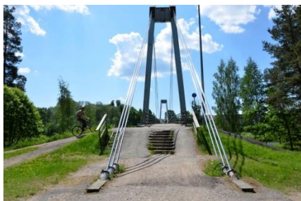
Attēls 5.33: Gājēju tilts pār Gauju pie Atpūtas parka
