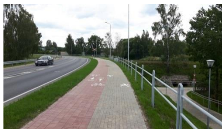
Attēls 5.24: Gājēju un velosipēdu ceļš Cempu ielā
