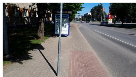
Attēls 5.8: Gājēju un velosipēdu ceļš pieturvietas zonā Stacijas ielā
