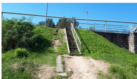
Attēls 5.36: Kāpnis no gājēju tilta uz Grīšļu ielu
