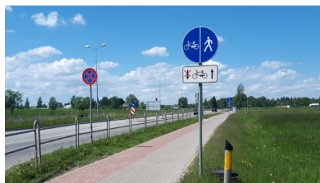
Attēls 5.6: Gājēju un velosipēdu ceļš Matīšu šosejā
