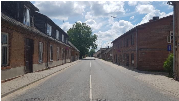
19. attēls. Skats no Ķieģeļu ielas un Limbažu ielas krustojuma D virzienā.
