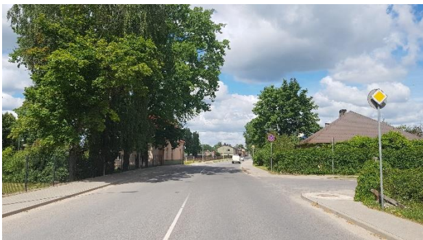
15. attēls. Skats no Upes ielas un Limbažu ielas krustojuma pa Limbažu ielu.
