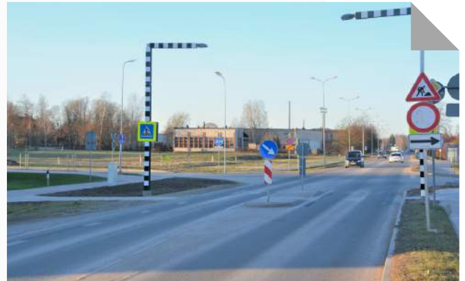
Uz Matīšu šosejas gājēju pārejas izbūvēta drošības salīņa
