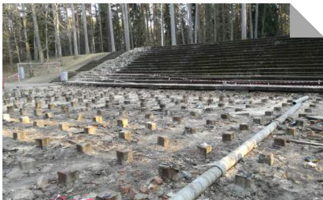
Valmieras estrādei demontētas vecās grīdas koka konstrukcijas
