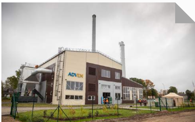
Katlumāja Dakstiņu ielā 1 ir aprīkota ar tehnoloģijām, kas ļauj dedzināt lētāku zemākas kvalitātes šķeldu
