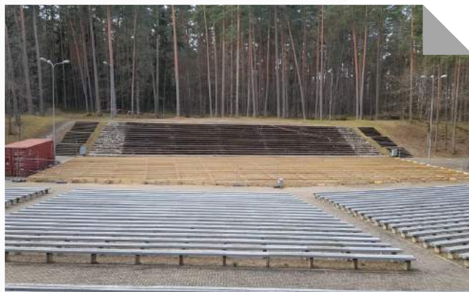
Valmieras estrādei uzstādītas jaunas grīdas konstrukcijas
