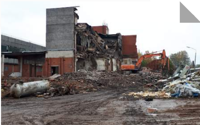
Degradētu būvju nojaukšana Rūpniecības ielā 1
