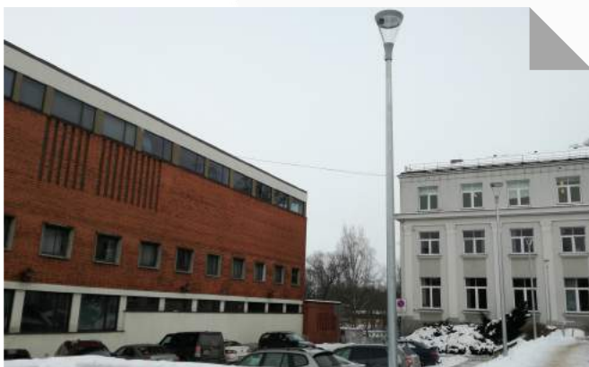
Energoefektīvā LED apgaismojuma laterna Valmieras rātslaukumā
