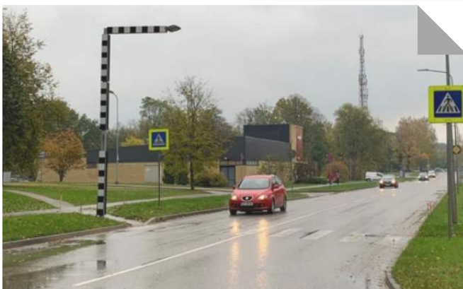
Rubenes ielas gājēju pāreja pirms drošības salīņas izbūves
