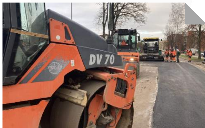
Beātes ielas asfaltēšana pēc siltumtrases izbūves
