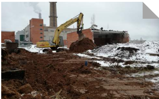
Degradēto būvju nojaukšana un sanācija bijušajā mazuta saimniecībā Dzelzceļa ielā 9
