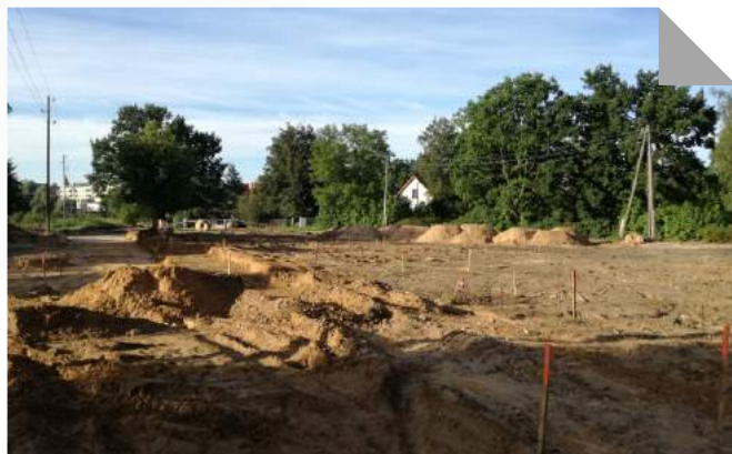
Krāču iela 4 rotaļu laukuma izbūves laikā
