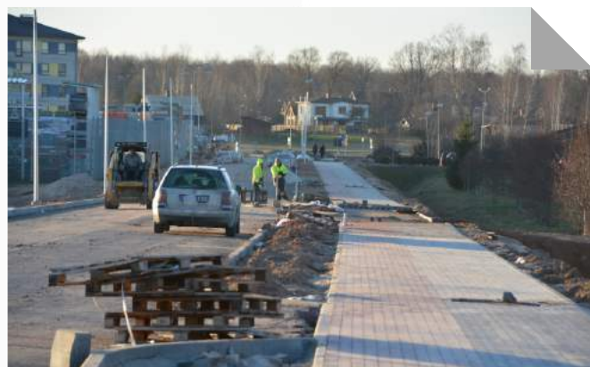
Mālu ielas pārbūve pirms ziemas tehnoloģiskā pārtraukuma
