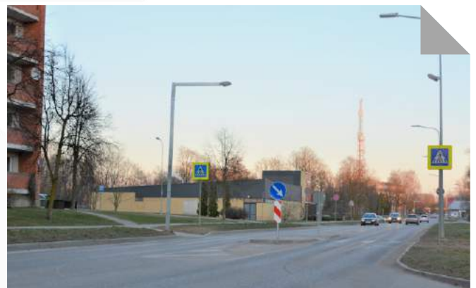
Uz Rubenes ielas gājēju pārejas izbūvēta drošības salīņa
