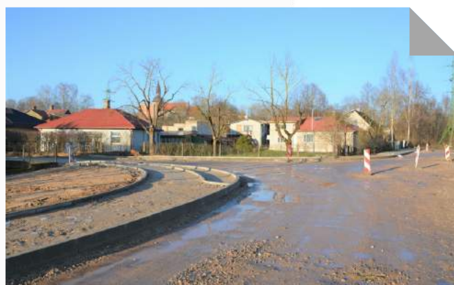
Teodora Ūdera un Tālavas ielas krustojuma pārbūve
