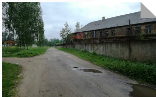
Dzelzceļa iela pirms pārbūves
